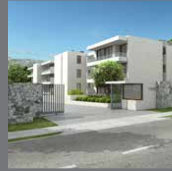
Edificio Fray León Las Condes
