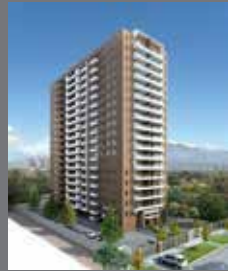
Edificio Alcalde Pedro Alarcón 818 San Miguel
