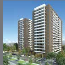
Edificio Alcalde Pedro Alarcón 887 San Miguel
