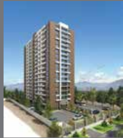
Edificio Alcalde Pedro Alarcón 901 San Miguel
