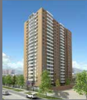
Edificio Alcalde Pedro Alarcón 851 San Miguel
