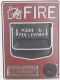
**f) Sistema de Alarma de Incendio:** red interconectada de sensores de humo a través de todos los espacios comunes del edificio y conectados a su vez a una central de control en conserjería. Además de estos sensores, el sistema cuenta con palancas manuales, en caso de que el sensor de humo no haya actuado, ubicadas en los pasillos de cada piso (2 por piso) y en puntos estratégicos de los subterráneos.
