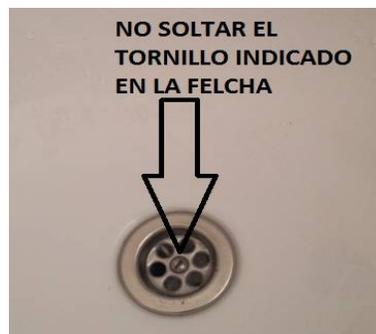
Si se encuentra el tornillo suelto, es muy probable que haya una filtración y ésta no solo puede afectar al propietario, sino que además puede ocasionar daños en los departamentos inmediatamente inferiores. Además, éste perno de ajuste por ningún motivo debe ser intervenido para realizar limpieza de sifones.
