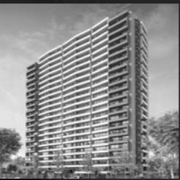
Edificio Terra Vista La Florida
