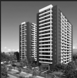
Edificio Alcalde Pedro Alarcón 887 San Miguel
