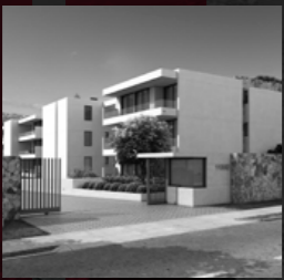
Edificio Fray Luis de León Las Condes
