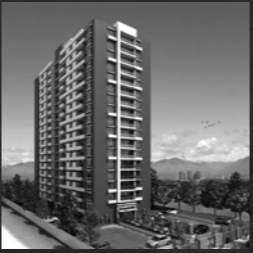
Edificio Alcalde Pedro Alarcón 901 San Miguel
