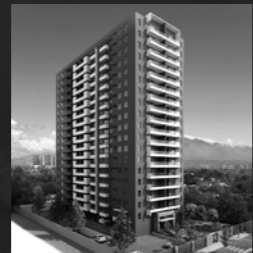
Edificio Alcalde Pedro Alarcón 818 San Miguel
