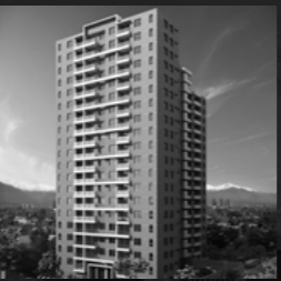
Edificio Silva 870 Las Condes
