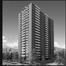
Edificio Alcalde Pedro Alarcón 851 San Miguel
