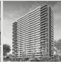
Edificio Terra Vista La Florida
