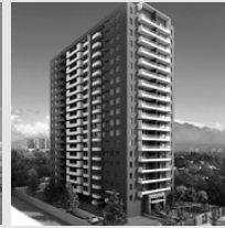
Edificio Alcalde Pedro Alarcón 818 San Miguel
