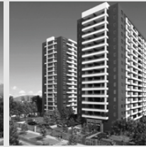
Edificio Alcalde Pedro Alarcón 887 San Miguel
