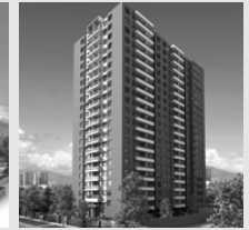
Edificio Alcalde Pedro Alarcón 851 San Miguel
