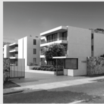
Edificio Fray Luis de León Las Condes
