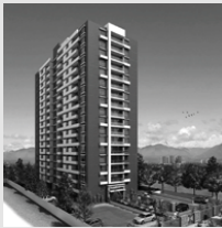
Edificio Alcalde Pedro Alarcón 901 San Miguel
