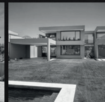
Casa Paseo Alcalá 10.429 La Dehesa
