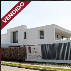
Casa Paseo Alcalá La Dehesa
