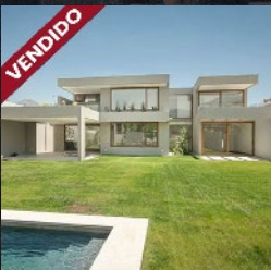
Casa Paseo Alcalá 10.429 La Dehesa
